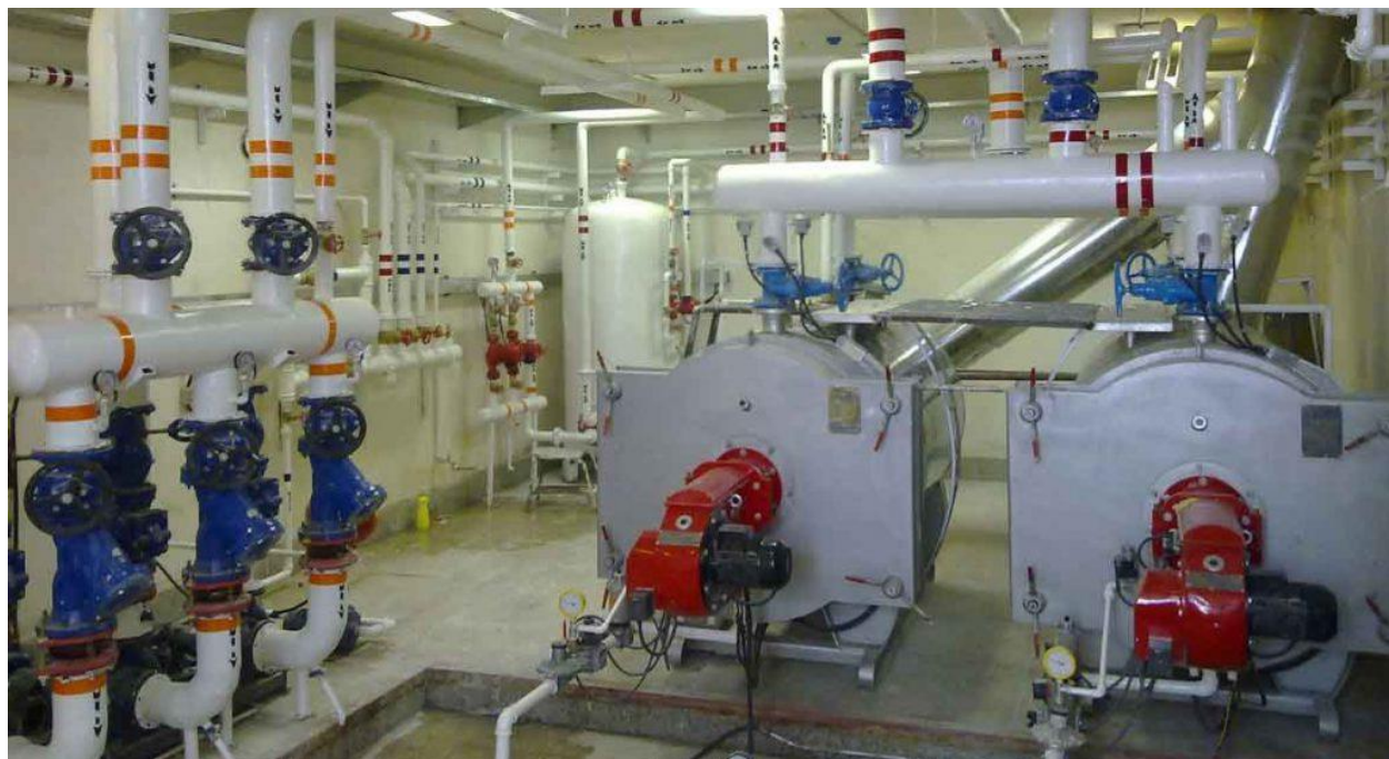
تعمیر موتورخانه آچاری ها
